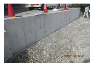
【盛土規制法許可】鷺の森町
