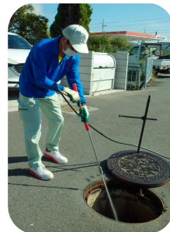
【マンホール内の薬剤散布】
