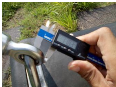
遊具点検(ブランコの吊り部材確認)
