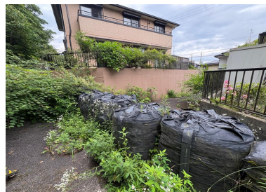
住宅付近には土嚢を設置
