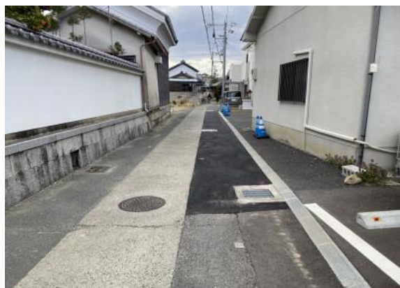
②市道67号(久代1丁目) 工事完了写真
