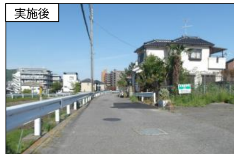
幹回り3.7mの支障木(撤去後) 通行可能幅員4.0m
