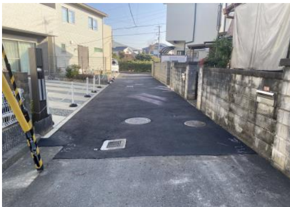
①市道98号(加茂2丁目) 工事完了写真
