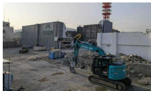
旧文化会館解体状況
