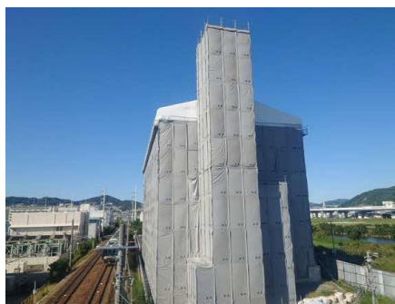
解体養生の状況(南側からの外観)
