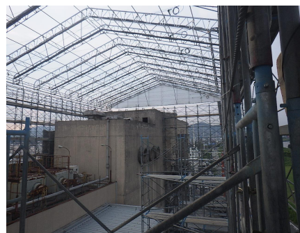
解体養生の状況(内観)
