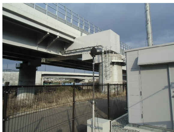
【図 7-3 測定の様子（川西文珠橋局）】
