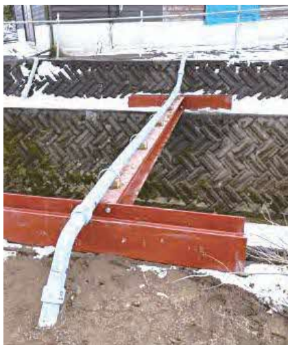
下水道管移設工事
