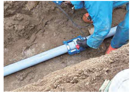
下水道管移設工事
