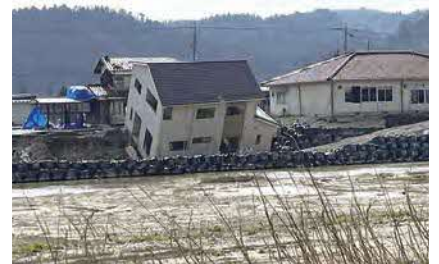
傾いたままの建物
