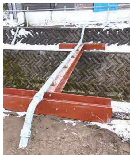
下水道管移設工事
