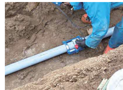
下水道管移設工事
