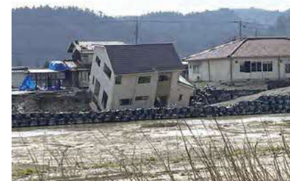
傾いたままの建物
