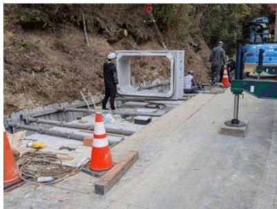
雨水管きょ築造工事
