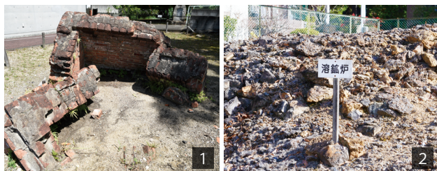
1. 真吹炉跡。溶鉱炉で溶かしたものをさらに熱し純度を上げる炉。ここで出来た、粗銅を型に流し固めて出荷する 2. 溶鉱炉跡。鉱石とコークス・石炭を高温で溶かして銅を取り出すための大型炉
