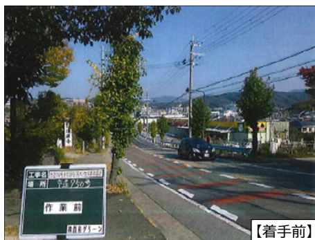
市道950号(西多田1丁目外地内)
