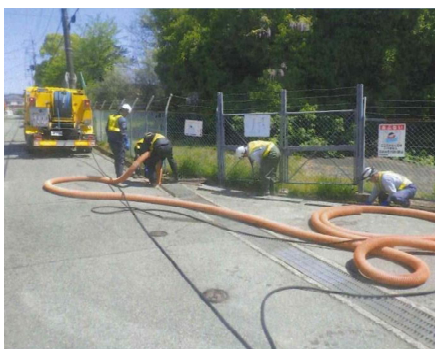
側溝浚渫状況
