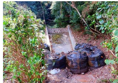
山麓には土嚢を設置
