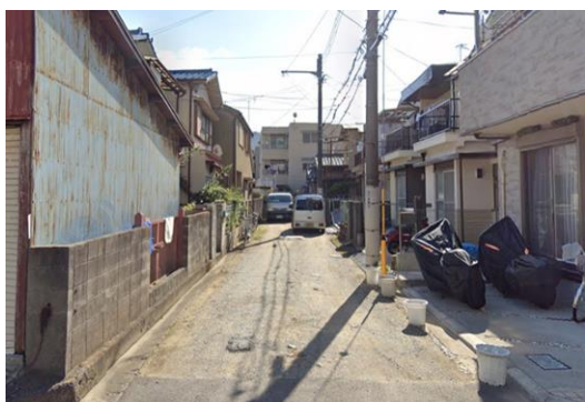
・工事前写真
