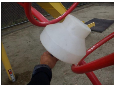
遊具点検（U字ラダーの開口部確認）
