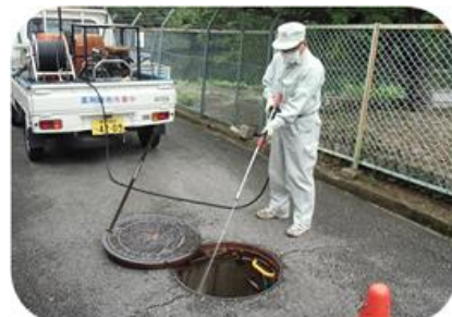
【マンホール内の薬剤散布】
