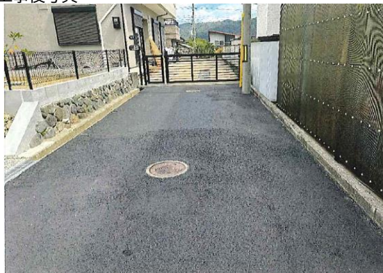
・工事後写真
