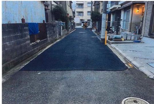
・工事後写真
