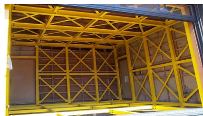
耐震シェルター
