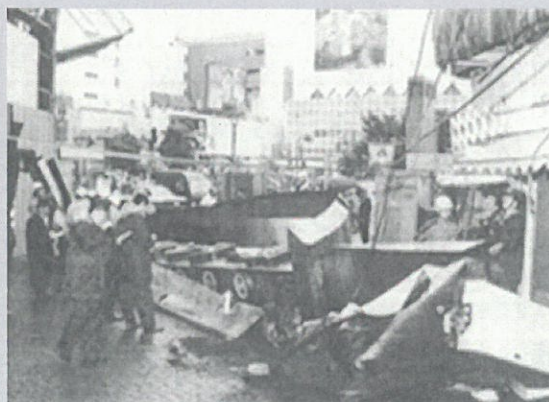
台風で落下した時の様子
