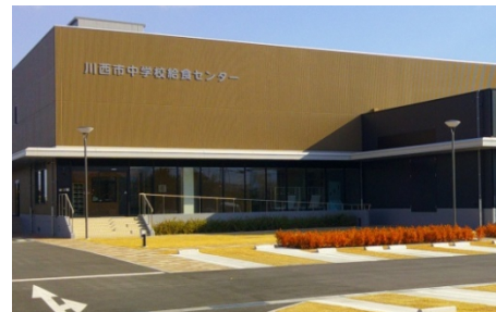
川西市中学校給食センター（久代）
