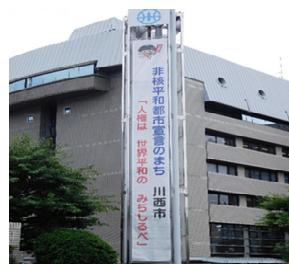
本庁舎 懸垂塔
