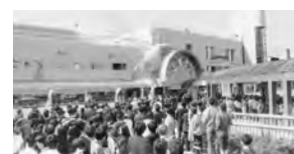
専門店や文化施設などが入った複合施設アステ川西
