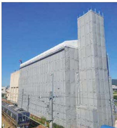
旧南部処理センター
