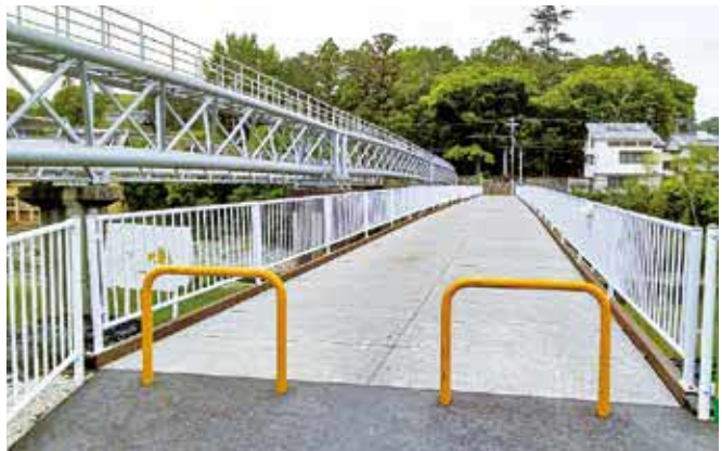
御社橋の仮橋（多田院1丁目・西多田1丁目）
