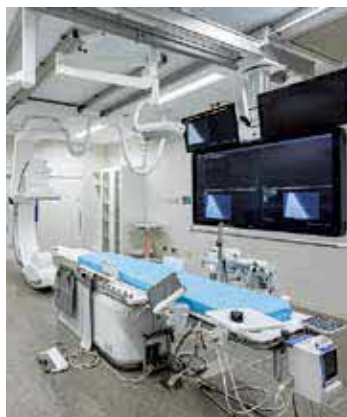
川西市立総合医療センター 手術室
