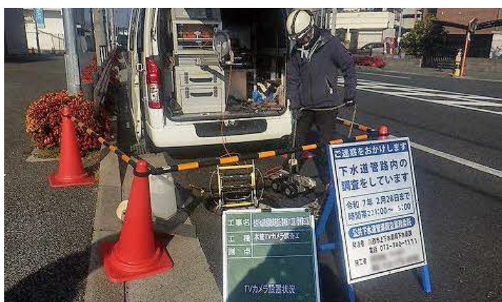
下水道管の調査の様子
