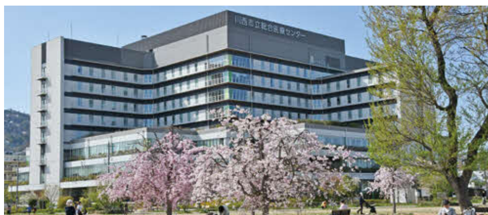
川西市立総合医療センター
