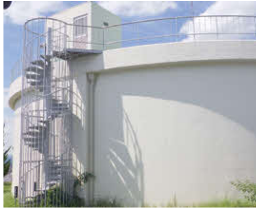
萩原台2号配水池（工事前）
