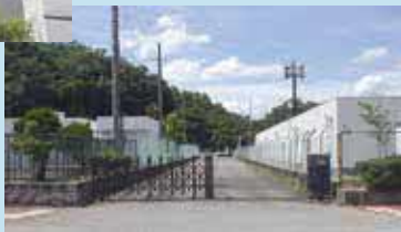
一庫低区配水池 (川西市) と 伏見台低区配水池 (猪名川町)
