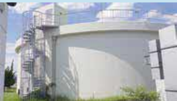
萩原台 2号配水池
