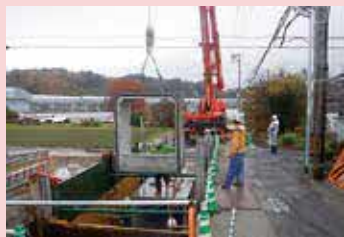
雨水管きょ築造工事
