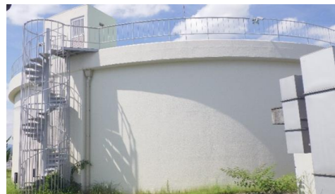
萩原台2号配水池
