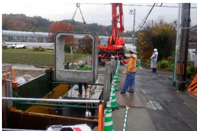
雨水管きよ築造工事
