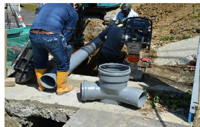
污水管きよ築造工事
