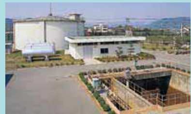
久代浄水場完成、井戸水を使った水道水を南部地区へ給水開始
