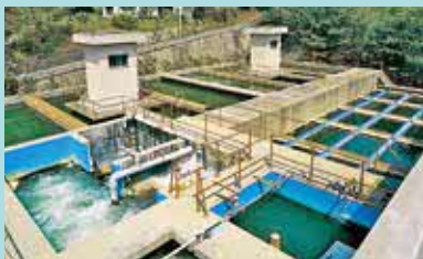
滝山浄水場完成、給水開始
