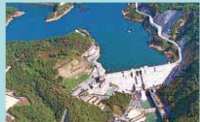
利水・治水を目的とした一庫ダムが完成
