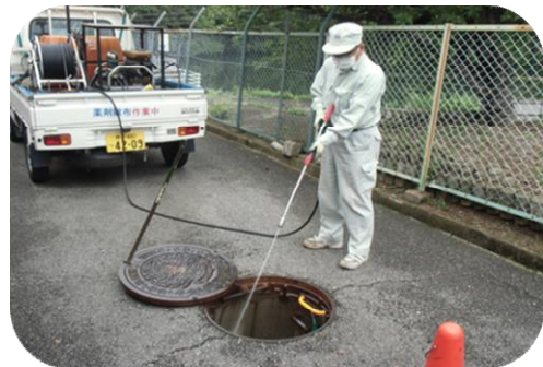
マンホール内の薬剤散布
