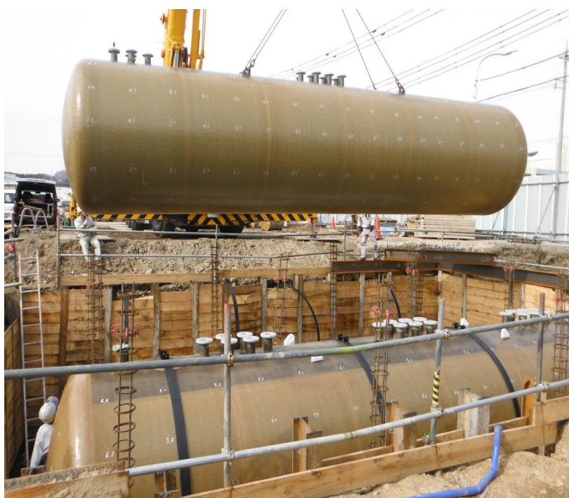
給油取扱所に埋設するタンクの検査
