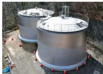
けやき坂高区配水池
