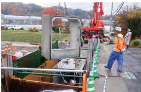
雨水管きよ築造工事
