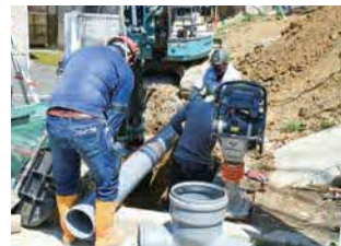
汚水管きよ 築造工事
