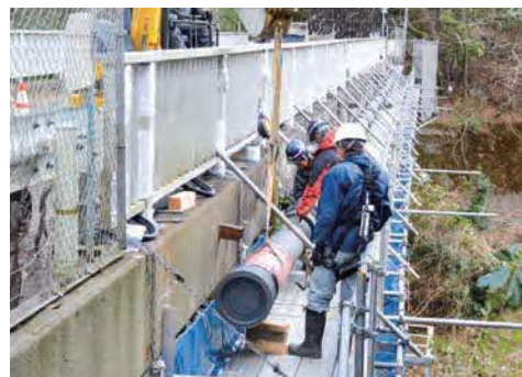
老朽化した送水管の改良工事
