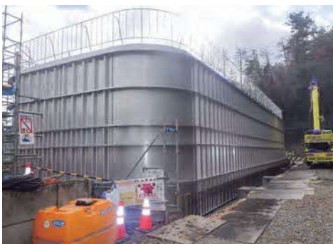
けやき坂低区配水池
