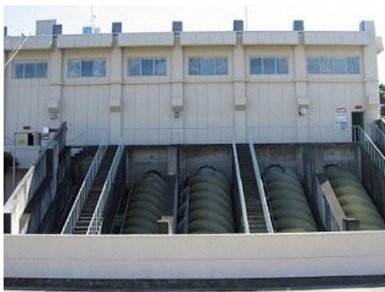
前川雨水ポンプ場 （昭和49年（1974年）建設）
