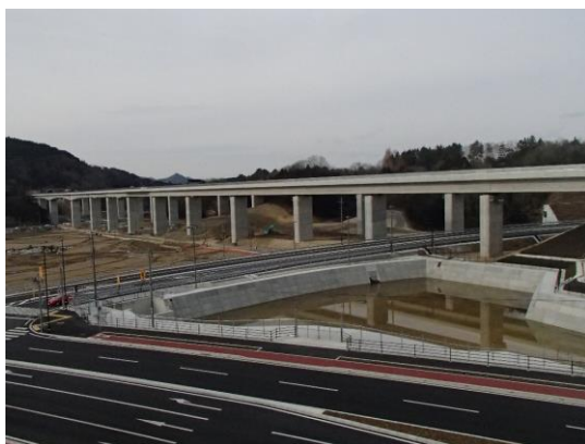
川西インターチェンジ1号調整池 (調整容量 6,625 m 3 )
