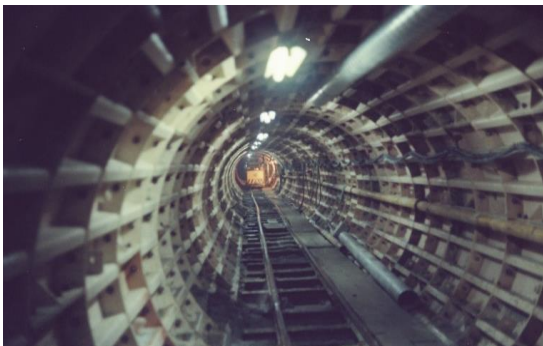
小戸1号雨水幹線施工状況
