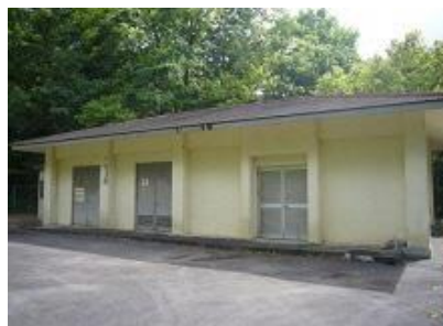
水明台汚水中継ポンプ場 (昭和61年(1986年)建設)
