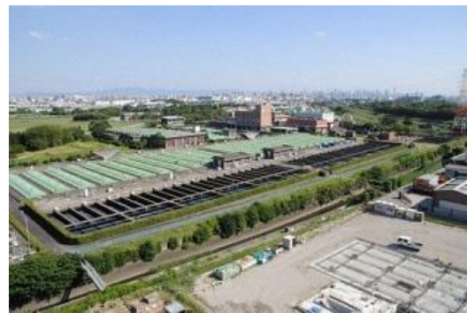
猪名川流域下水道原田処理場
