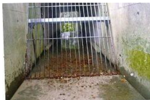
スクリーンゴミ処分後
