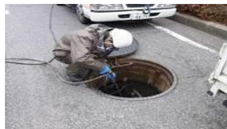
マンホール内の清掃
