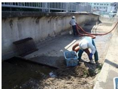
土砂浚渫作業中
