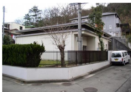
満願寺汚水中継ポンプ場 (昭和63年(1988年)建設)
