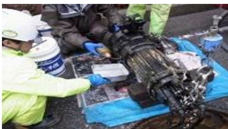
ポンプの点検、清掃
