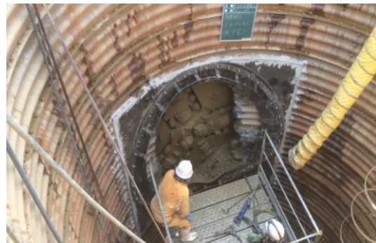
出在家1号雨水幹線セミシールド到達状況
