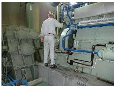
スクリューポンプのエンジン点検保守
