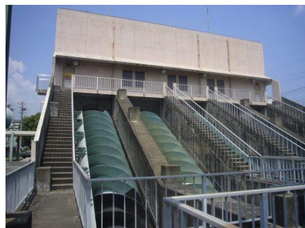
加茂雨水ポンプ場 （昭和56年（1981年）建設）
