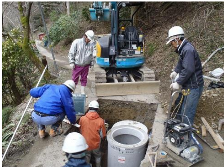
黒川地区污水管渠築造工事
