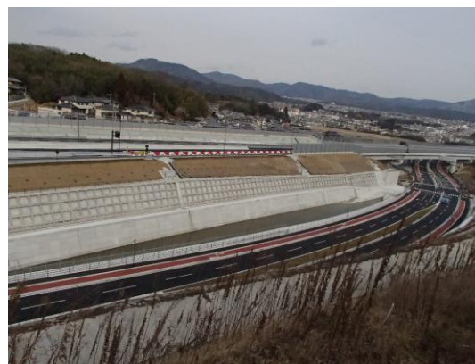
川西インターチェンジ2号調整池 (調整容量 5,480 m 3 )
