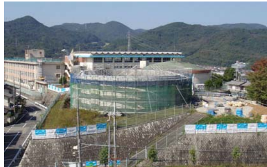
萩原台配水池の更新工事状況
