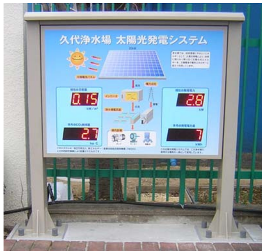
太陽光発電システム表示パネル
