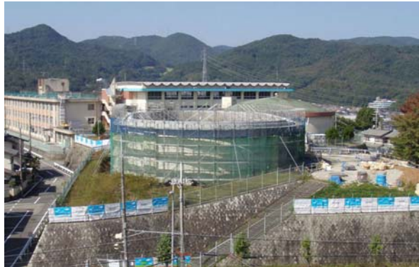
萩原台配水池の更新工事状況
