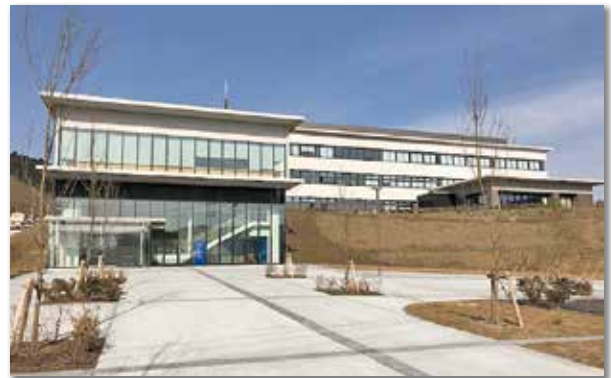
平成30年10月1日に開庁した新庁舎の女川町役場
