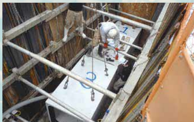
雨水管渠の布設
