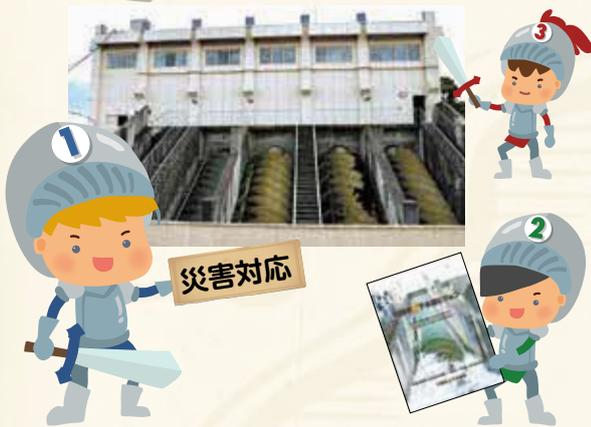
「残るカードは1枚。公共下水道の大きな役割は水害を防ぐことだから、きっとここにポイントとなるカードがあるはず。ここは雨水をくみ上げて川に流すポンプ場だね」
