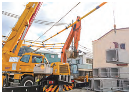
雨水管きよ築造工事
