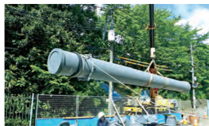
老朽化した送水管の改良工事
