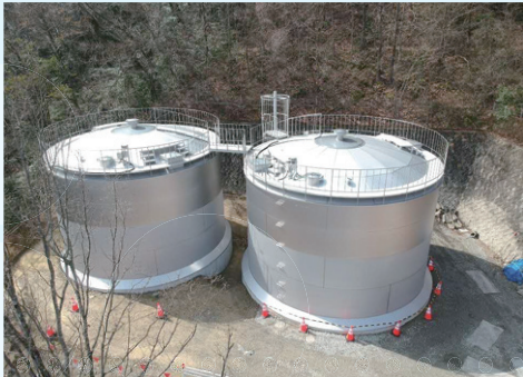
けやき坂高区配水池
