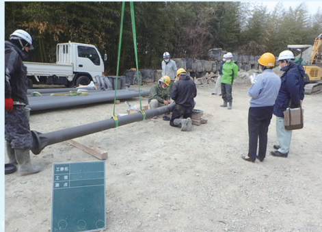
老朽化した送水管の改良工事
