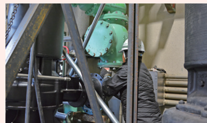
汚水中継ポンプ場改築工事
