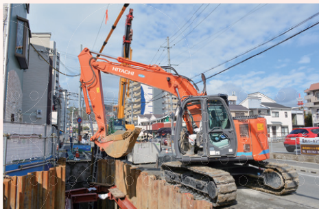
雨水管きょ築造工事
