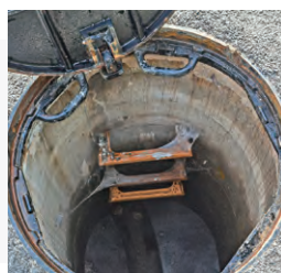
マンホール内部の状況
