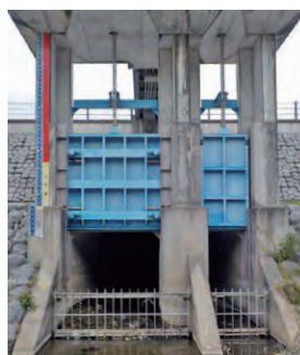
出在家第1排水樋門
