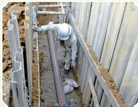
汚水管きよ工事
