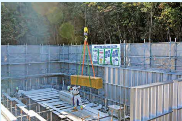
けやき坂配水池の耐震化工事
