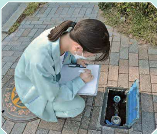
水道メーターの確認
