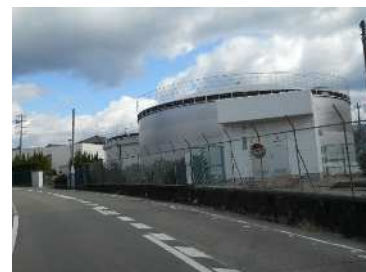
大和低区配水場
