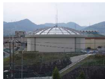
萩原台配水場
