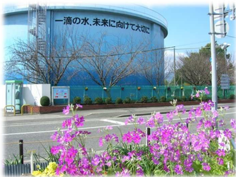
久代浄水場 (久代配水池)
