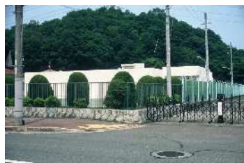
一庫低区配水場
