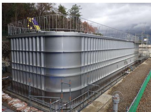
けやき坂低区配水池
