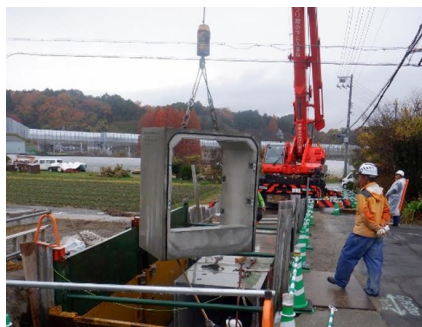
雨水管きょ築造工事
