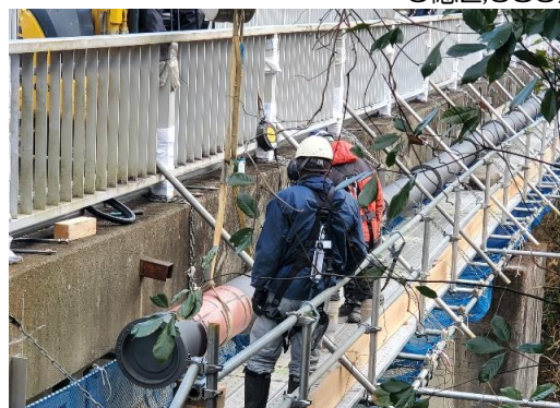
老朽化した送水管の改良工事
