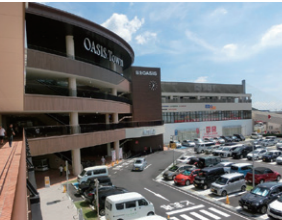
↑ キセラ川西にオープンした大型商業施設
