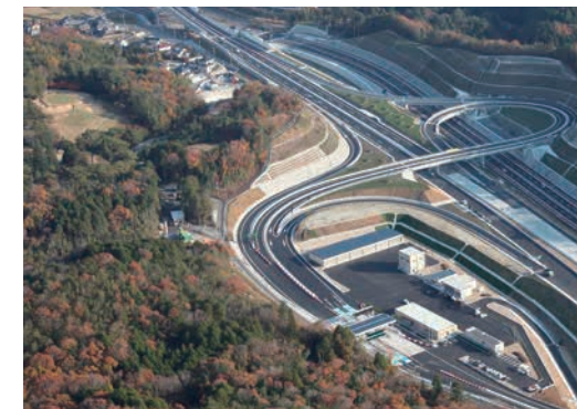
川西インターチェンジ [写真は2017年11月時点、NEXCO西日本]
