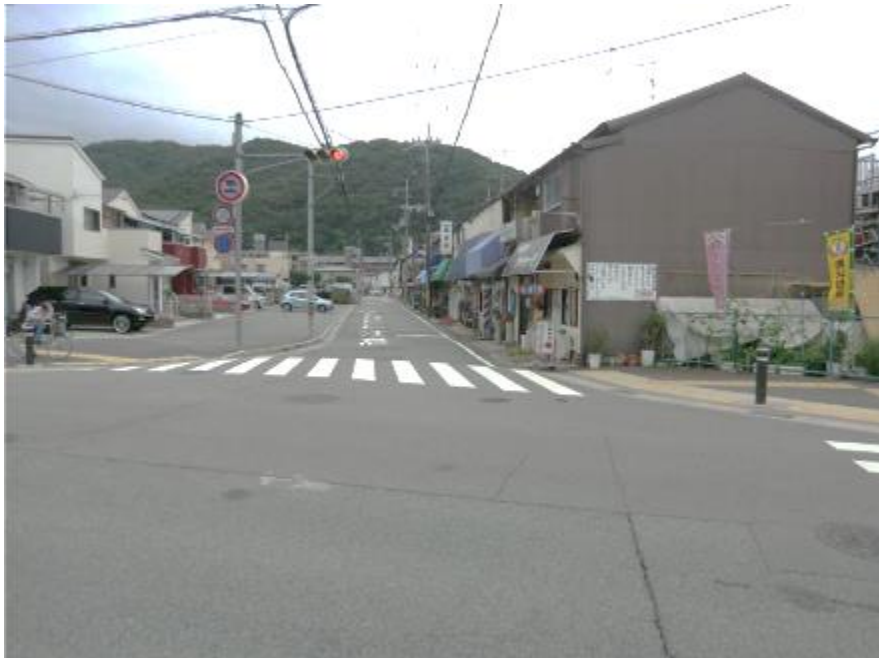
豊川橋山手線(着手前)
