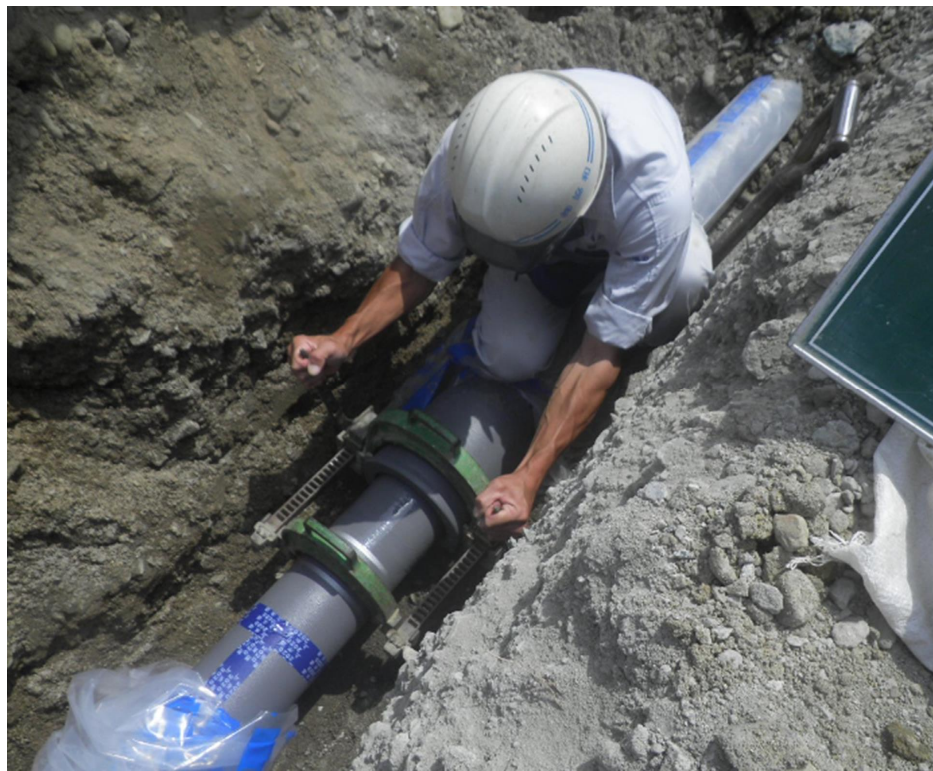
配水管敷設状況
