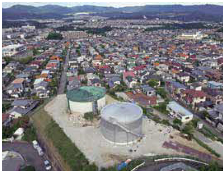
配水池築造工事
