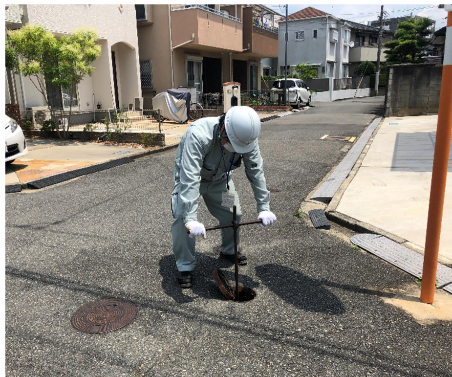
断水・洗管状況
