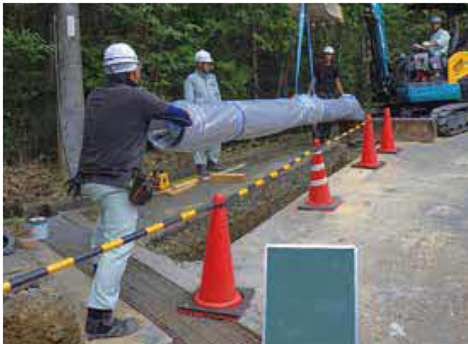
耐震管 敷設状況
