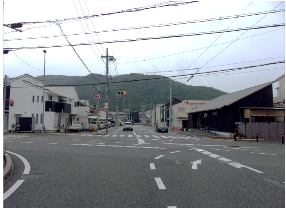
豊川橋山手線(経過途中)
