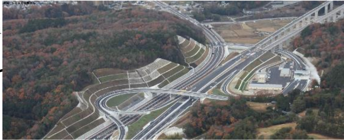
川西インターチェンジ全景
