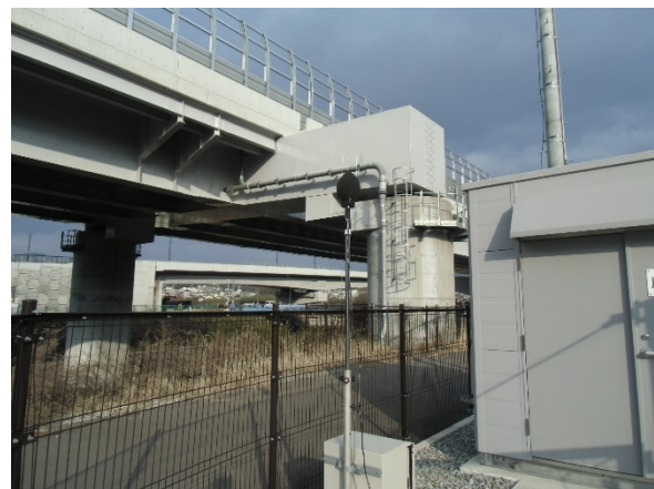
【図 7-3 測定の様子（川西文珠橋局）】
