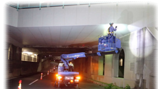
作業車等による点検（交通規制あり）
