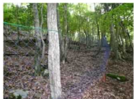
植生保護柵の設置
