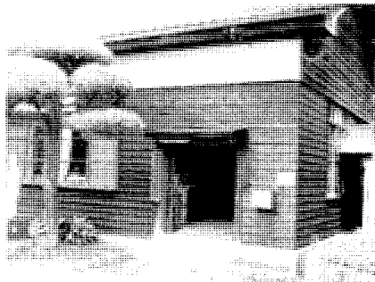
黒川公民館 出入口、外壁修繕
