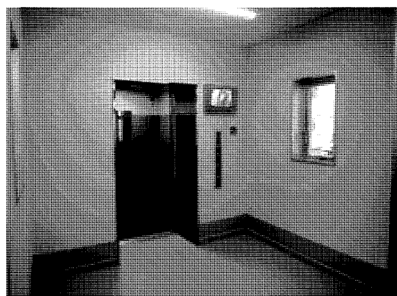
竣工状況（エレベータホール）
