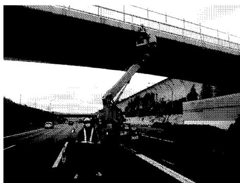
【 中大野橋昼間点検状況 】
