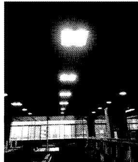
照明器具修繕(4階書架天井)
