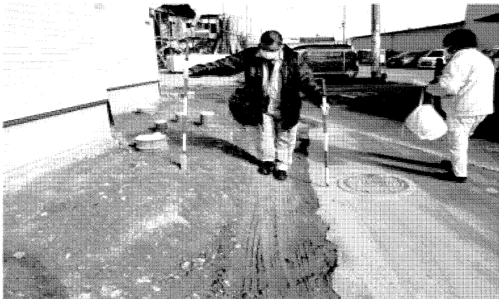
確定測量作業の様子
