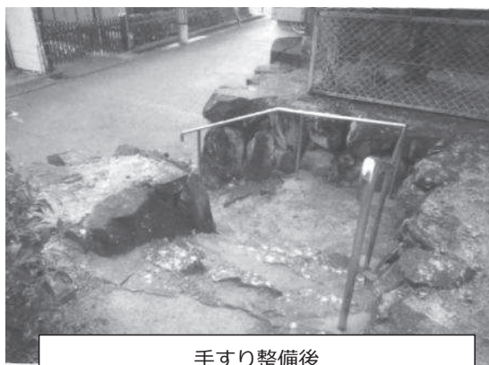
手すり整備後
