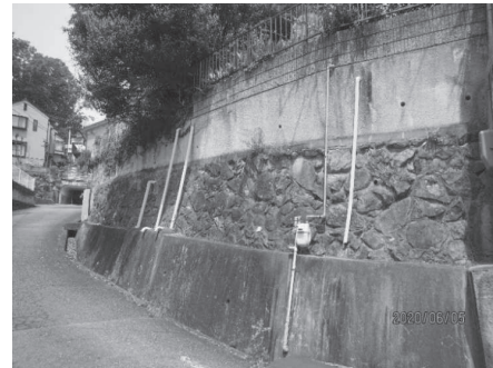
宅地防災パトロールを行い、宅地災害防止を図った
