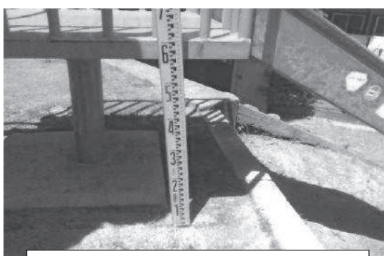
遊具定期点検（すべり台落下高さ確認）
