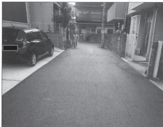
工事完了後写真
