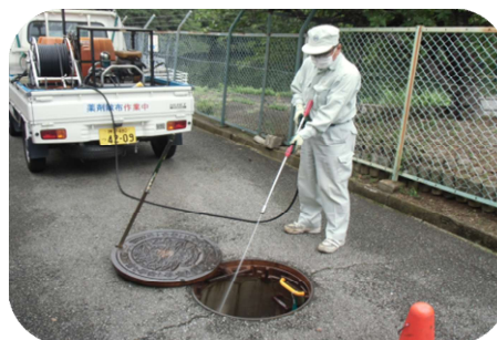
マンホール内の薬剤散布
