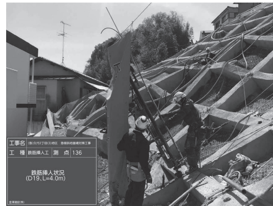
鉄筋挿入工
