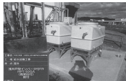
給水設備修繕
